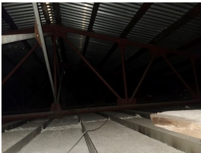
Pozn. stávající podhled v garážích (heraklitové desky + ocelové svařované T profily)
